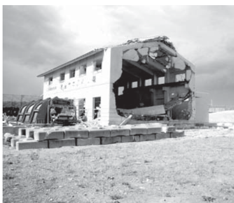
破壊された花笠第2排水機場
