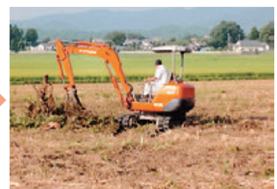
抜根作業の状況
