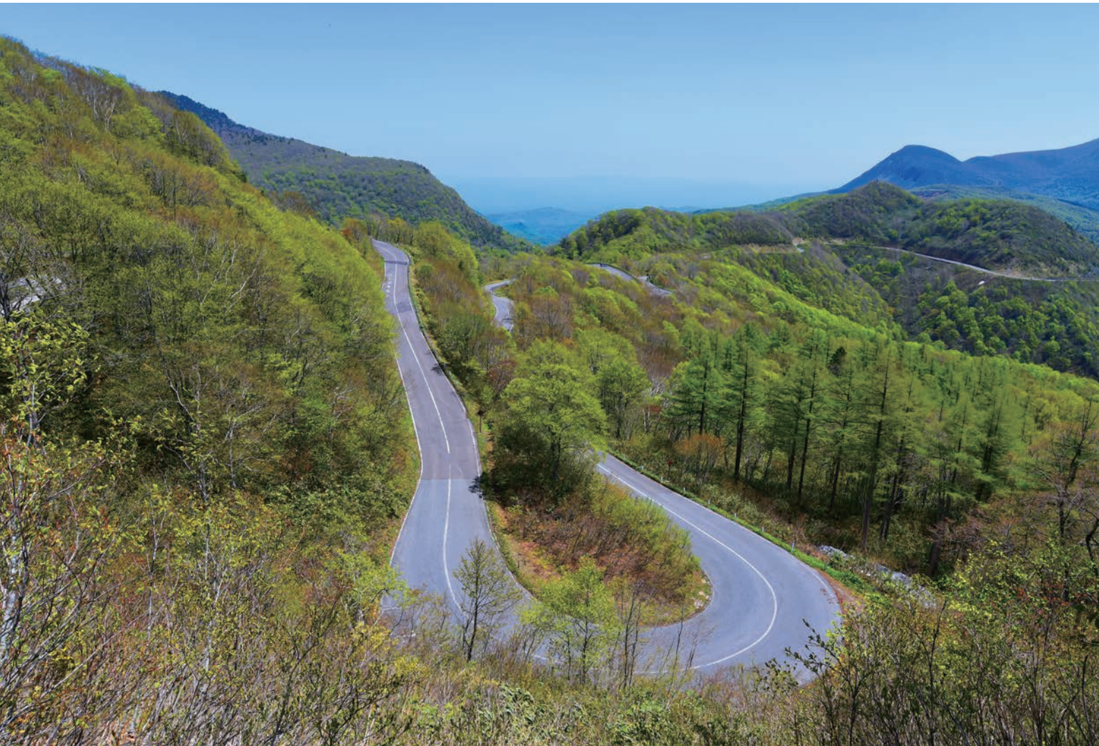
土湯温泉～吾妻スカイライン
