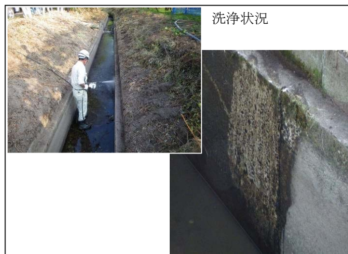
図 6.1-1 動力噴霧機など下地処理の一例
