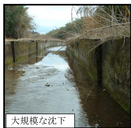
図 3-1 簡易補修には適さない変状例
