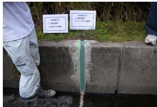
完了（弾性シーリング材）
