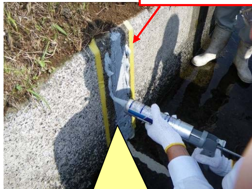
塗布・充てん状況
