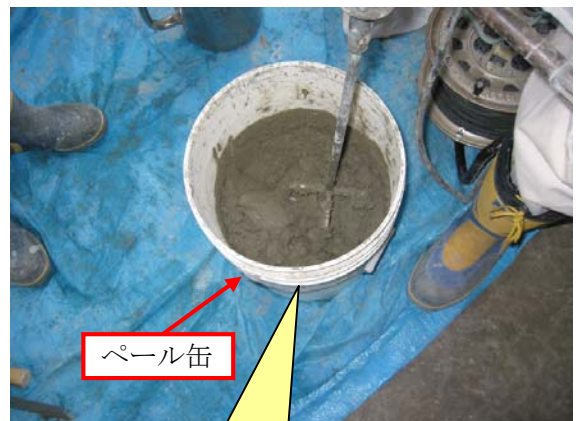
練り混ぜ状況
