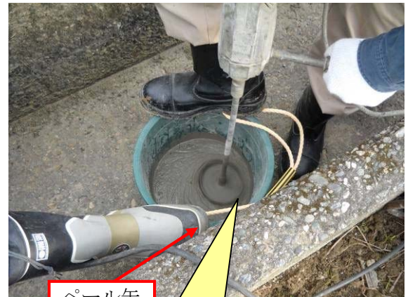
練り混ぜ状況
