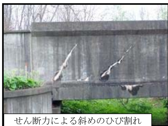
図 3-1 簡易補修には適さない変状例
