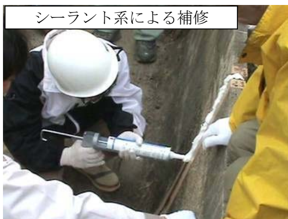
図 5-1 補修材料別施工例
