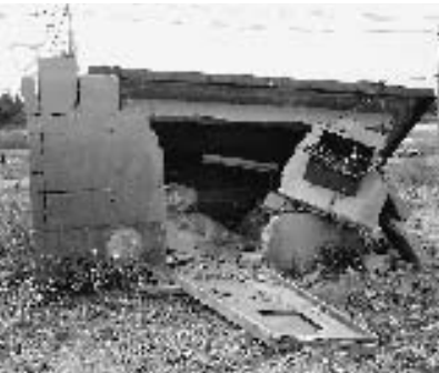
須賀川市 西ノ内第1揚水機
