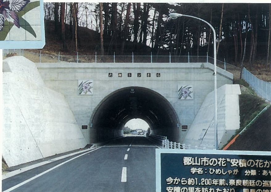
大槻トンネル（郡山西部地区）
