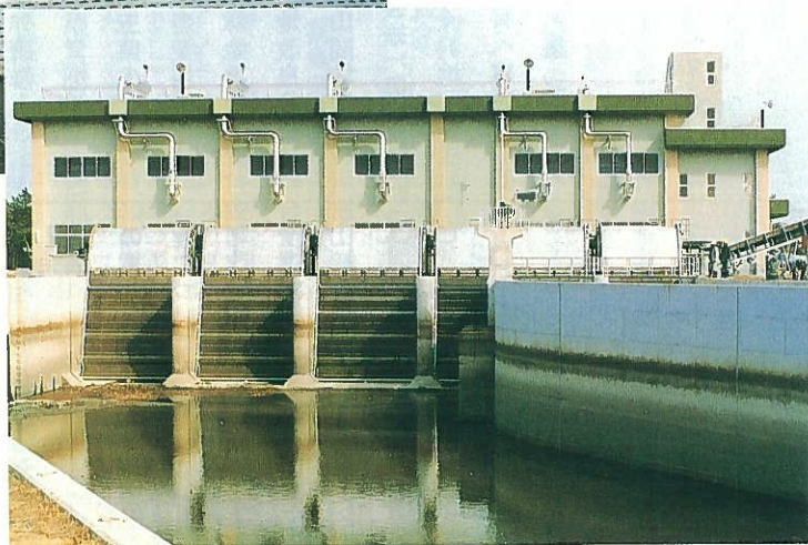
八沢排水機場
