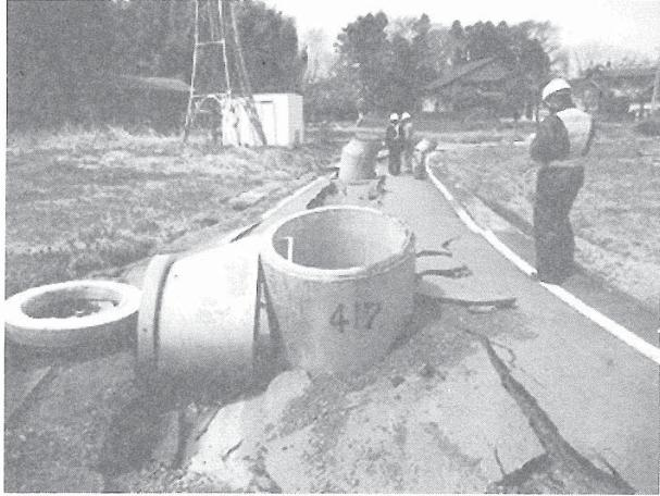
液状化によるマンホール浮上・破壊
