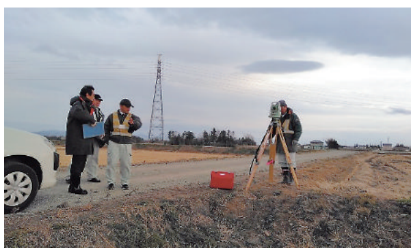
現地による確認 測量プロセス (前田沢地区)
