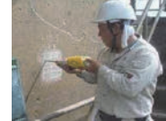
老朽化した施設の機能診断
