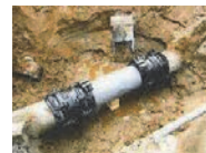
漏水防止のための整備
