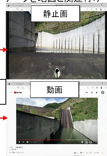
自動ルート飛行で撮影したデータを地図と関連付け
