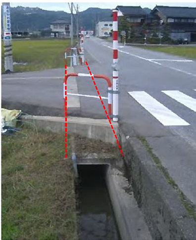
(農業用水路の道路占用箇所)
