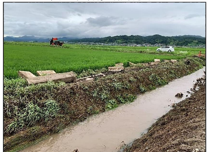
令和2年7月豪雨被害状況
