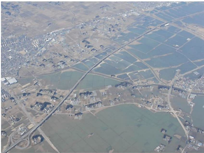
津波浸水状況（名取市付近）
