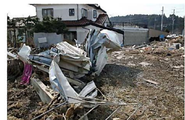
洪水による建物の被害
