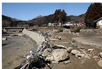
洪水による橋の被害
