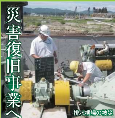
排水機場の被災
