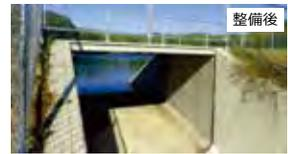
ため池の洪水吐きの改修(洪水流下能力の増加)
